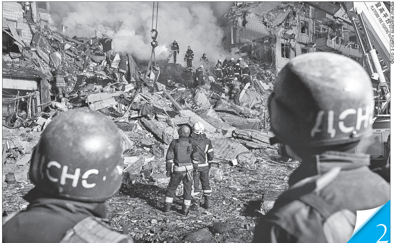
У Дніпрі 14 січня ворожа ракета влучила у дев'ятиповерховий будинок, зруйнувавши два під'їзди з дев'ятого по другий поверхи (72 квартири знищено, понад 230 пошкоджено)
