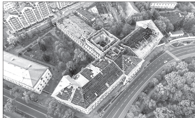
Що дах у будівлі дірявий, добре видно з висоти пташиного польоту
