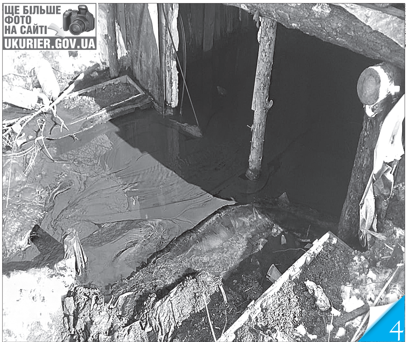
Вхід у бліндаж, затоплений відходами
