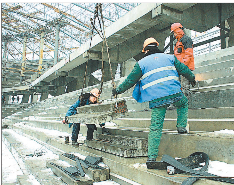
На будівництві нового стадіону робота кипить цілодобово
