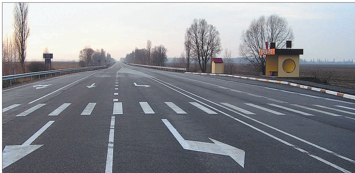
Дорога Кіпті — Глухів — Бачівськ після капітального ремонту
